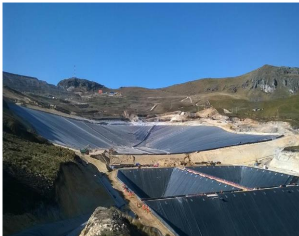
Construcción de PADs de Lixiviación Fases 3A, 3, 2A, 2, 1A y 1 – Tantahuatay Cementos Argos
