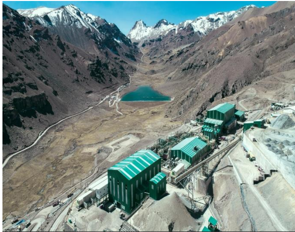
Construcción de Planta de Procesos – Tambomayo Buenaventura
