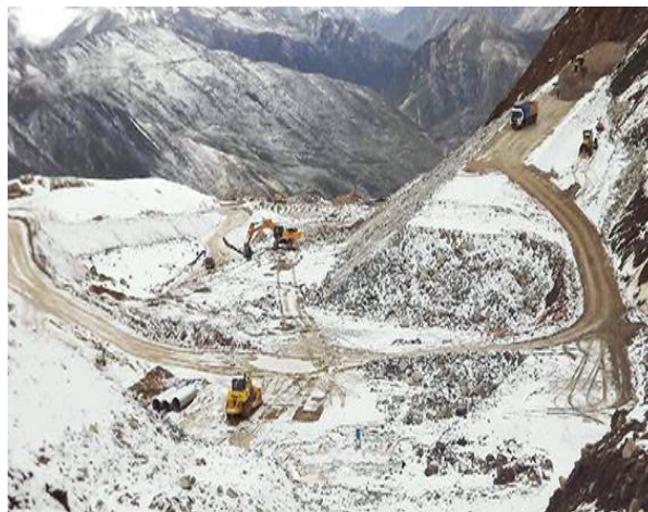
Preparación de sitio, construcción de accesos y plataformas – Toromocho Chinalco
