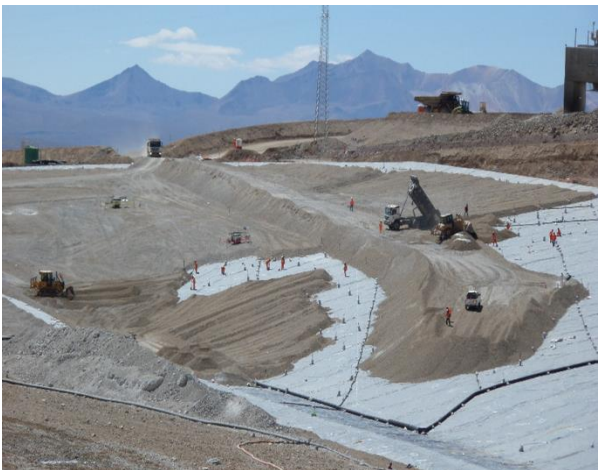
Construcción del PADs de lixiviación Fase 3B, 3A, 2A, 2B y 1 – Pucamarca Minsur
